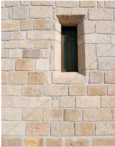
Fig. 2 - Pormenor do alçado sul da capela-mor. Distinguem-se orifícios de forx , uma cruz da Via-Sacra junto ao vão e mais duas cruzes localizadas na base do aparelho.
